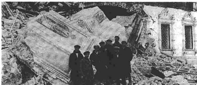
Ο πυρετός της εκβιομηχάνησης δεν άφηνε τίποτα όρθιο στην ΕΣΣΔ των αρχών του '30. Εδώ, στο Νίζνι Νόβγκοροντ εργάτες ποζάρουν μπροστά από τα ερείπια μίας εκκλησίας που κατεδαφίστηκε προκειμένου να κτιστεί ένα εργοστάσιο παραγωγής αυτοκινήτων
