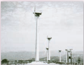
Αιολικό πάρκο σε βόφο πάνω από τον Μαραθόκαμπο της Σάμου.
